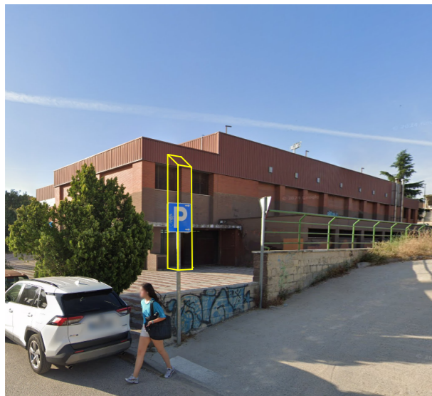
FOTOGRAFÍA FACHADA CON EMPLAZAMIENTO PLATAFORMA ELEVADORA
